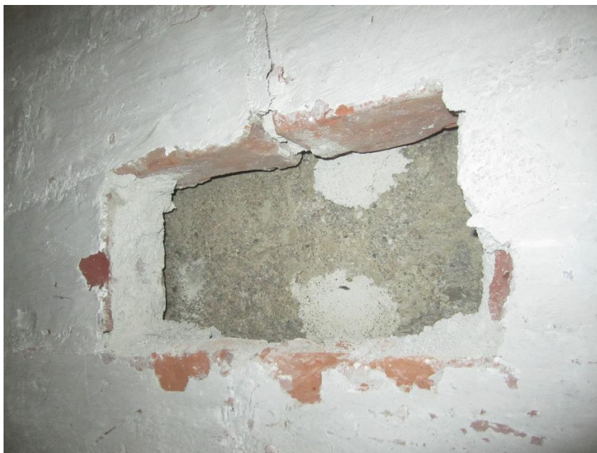
Kuva 3. Verhousiilen poisto kellarin maanvastaisen seinän yläosasta.
