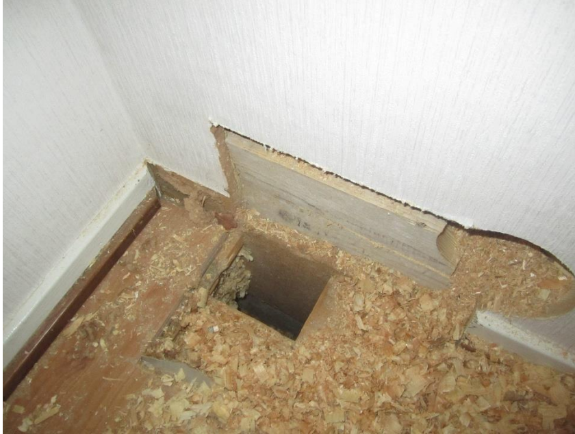
Kuva 9. Välipohjan rakenneavaus.
