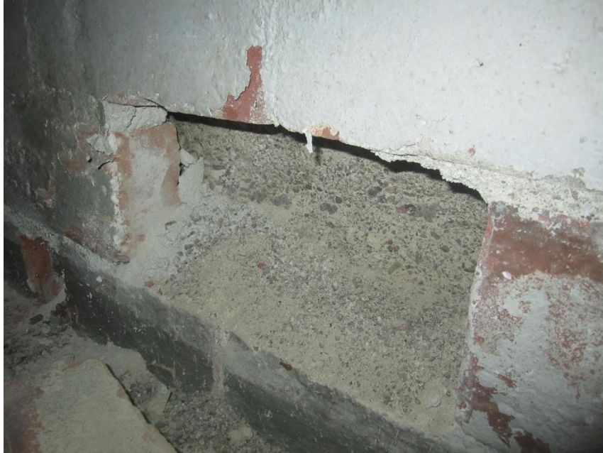
Kuva 4. Verhoustiilen poisto kellarin maanvastaisen seinän alaosasta.
