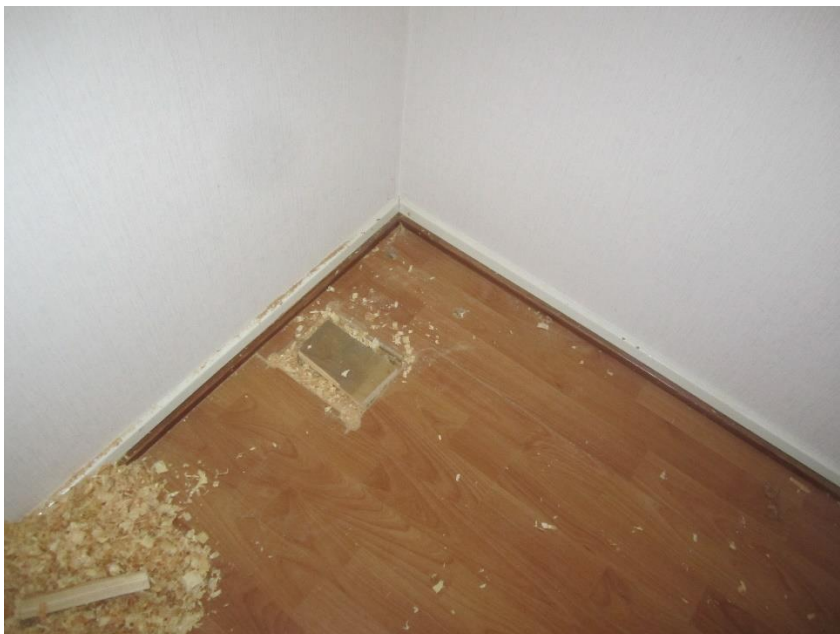
Kuva 10. Toinen välipohjan rakenneavauskohta.
